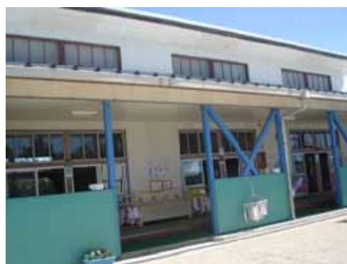
外から耐震工事をした玉垣保育所
