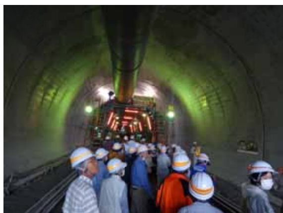
トンネル内部・コンクリート打ちの準備中
