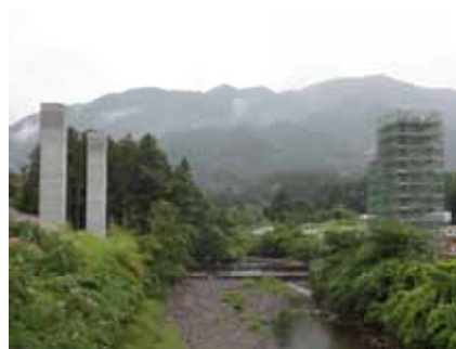
御幣川を越える橋の橋脚
