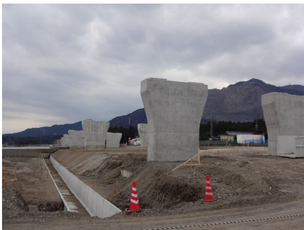
新名神高速道路の工事現場（山本町）
