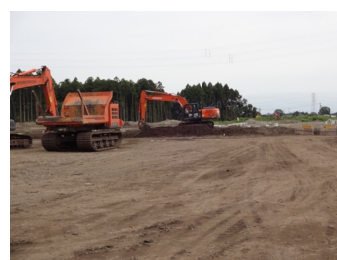
造成工事が進む工業団地
