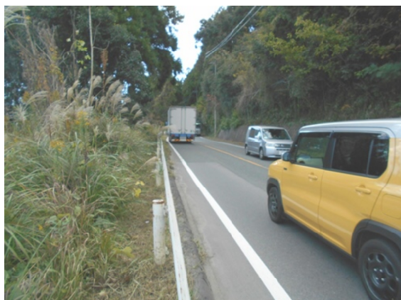
国道306号・伊船町～東庄内町の山沿い区間
