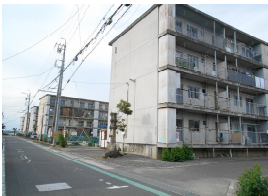
市営岡田団地・現在142世帯が暮らす
