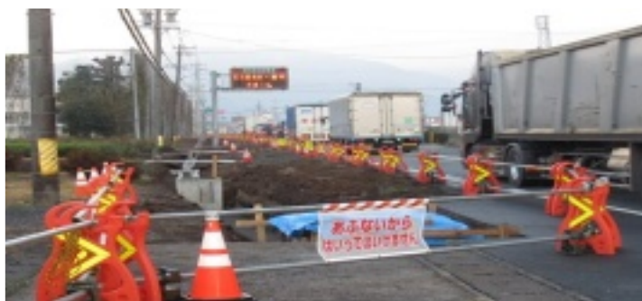
鈴鹿IC入口の工事現場、左が鈴峰中
