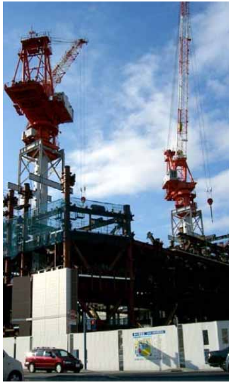
工事の進む新庁舎建設現場
