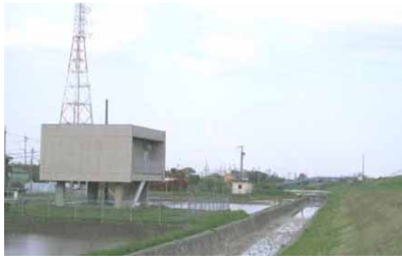
鈴鹿川沿いに点在する水源井戸(西富田町)
