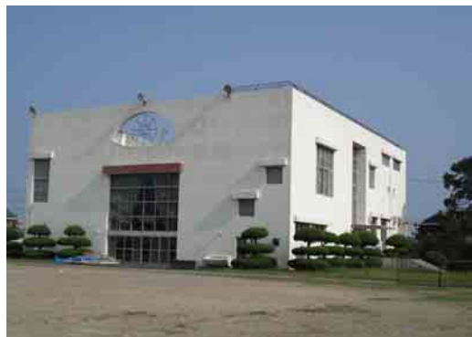
改修工事の始まる勤労青少年ホーム
