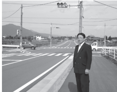
半分開通した国道306号バイパス
