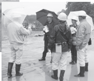
党市議団でゴミプラント建設現場視察
