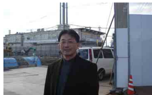
現消防庁舎の前に新庁舎建設中
