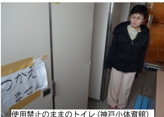
使用禁止のままのトイレ(神戸小体育館)
