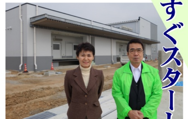
完成間近な中学校給食センター（相生4丁目）
