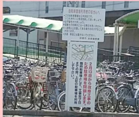
自転車駐車場（有料） 近鉄鈴鹿市駅前工事始まる
