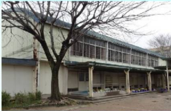
石薬師小学校体育館(1974年建設)
