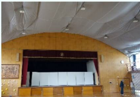
天井からの落下物危険防止ネットが張られた体育館(河曲小学校)
