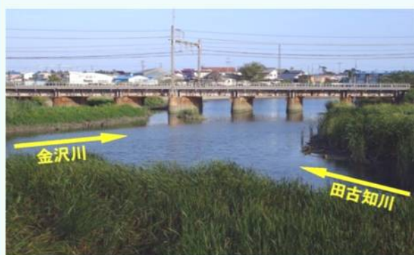
金沢川下流 近鉄鉄道橋付近
