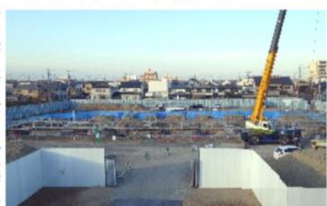
西条保育所の新築工事がすすむ市有地
