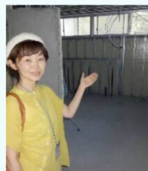
改修工事中のトイレ(神戸小)
